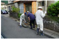
c007003011 側溝のコンクリート蓋
